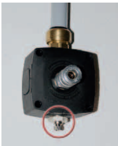
Tiefpunkt: An der tiefsten Stelle des Rohrleitungssystems empfiehlt der Fachmann den Einbau eines Anschlusses mit Wasserablass (Kreis), da sich dort das meiste Kondensat sammelt. Bild: Mareis
