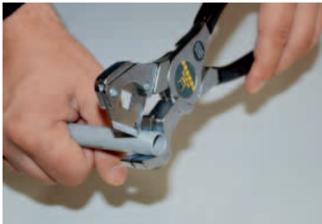
Einschneidende Maßnahme: Das Ablängen der Kunststoffrohre geschieht mit einer Rohrschere. Bild: Mareis
