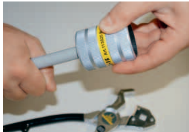
Feinarbeit: Das spezielle Entgratwerkzeug beseitigt scharfe Ränder, die bei der Montage die Dichtung beschädigen und damit die Dichtigkeit des Systems beeinflussen könnten. Bild: Mareis
