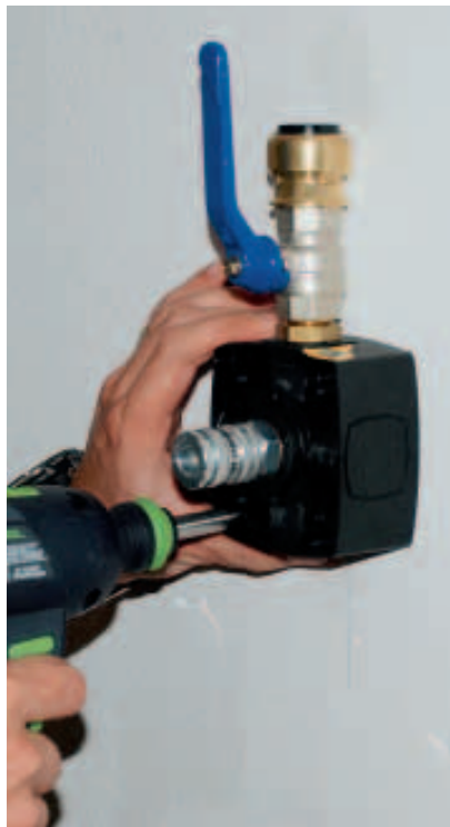
Einfacher Aufbau: Das „Click-It“-System in Kombination mit den neuen modularen Anschlussdosen ist auch vom Werkstattprofi schnell installiert. Bilder: Mareis
