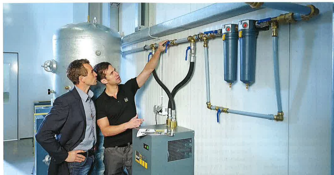
Moderne Materialien und Baukastenelemente erleichtern die Installation eines neuen Druckluftnetzes
