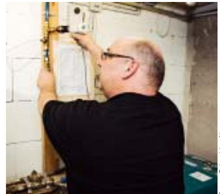
Ein Anschluss für die Drucktaupunktmessung wird installiert
